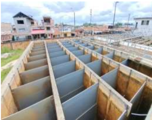
CULMINACIÓN DE RENOVACIÓN DE FLOCULADORES EN PTAP PARA MEJORAR CALIDAD DEL AGUA POTABLE (Fondo de Inversión).
